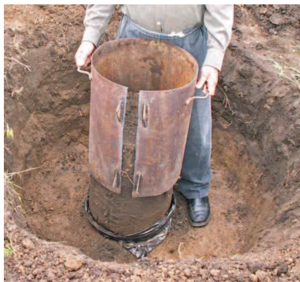
Рис. 2. Снятие корпуса после подведения полиэтиленовой оболочки под монолит
