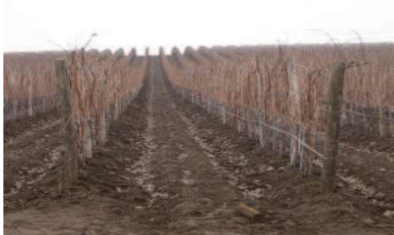
Рис. 2. Сооружение подпорной конструкции с использованием различных материалов – деревянных кольев, металлических прутьев и железобетонных столбов сразу после посадки
